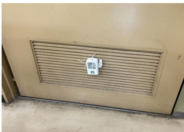
図29 ガラリへのCO2ロガー設置の様子
