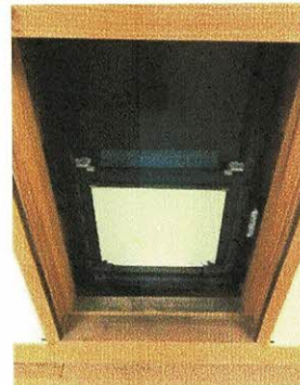
写真 2-1 ムラージュ室の外壁窓（と同形式の窓）と二重壁の室内側窓を開放した状態
