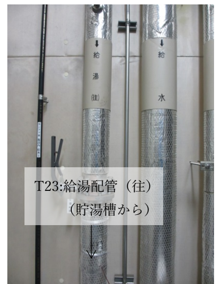
写真 2.17 給湯配管 (往)
