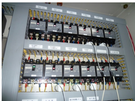
写真 2.19 分電盤：各ポンプの電流値が分かる。
