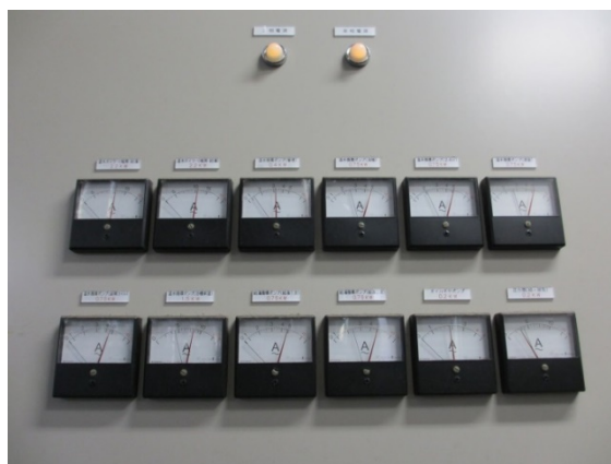
写真 2.19 分電盤：各ポンプの電流値が分かる。
