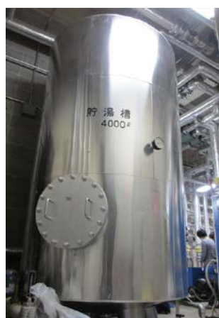
写真 2.5 貯湯槽
