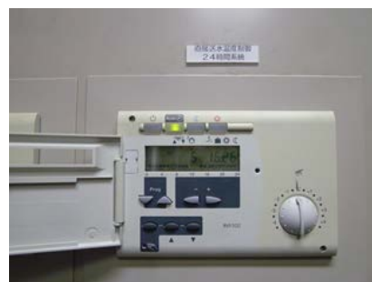
写真 2.10 暖房の ON, OFF が設定されている
