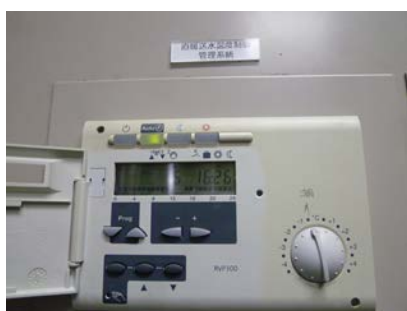
写真 2.10 暖房の ON, OFF が設定されている
