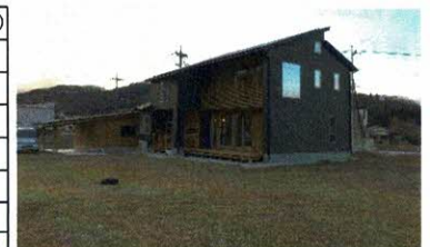
写真1 Y邸外観（南東方向より）
