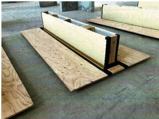
写真 4-6 間仕切り壁と最上階天井
